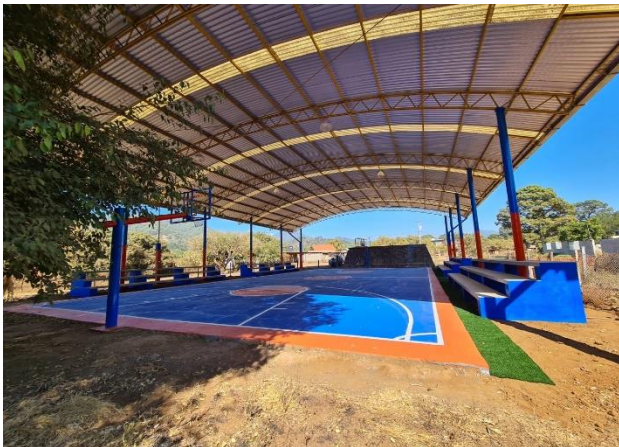
Rehabilitación cancha Zoromútar
