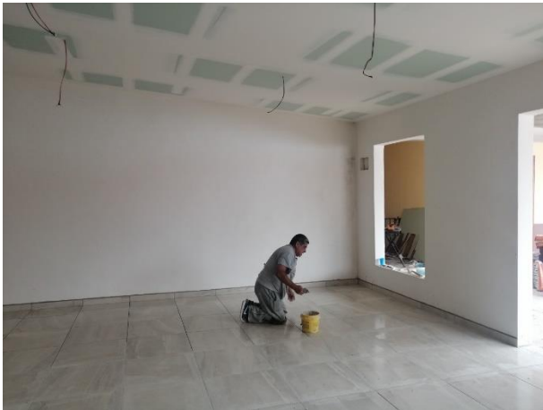
Ampliación del Ayuntamiento tercera etapa
