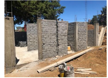
Sanitarios Escuela Morelos
