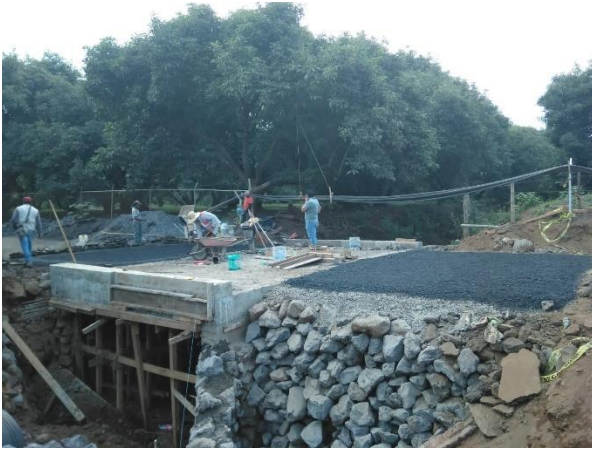
Puente el Cuate
