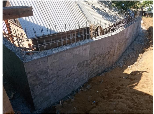
Muro de contención Santa Catarina
