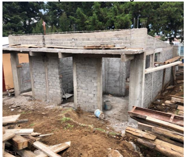
Sanitarios escuela Morelos
