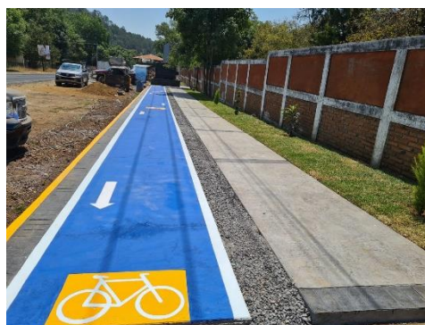
Rehabilitación Boulevard Tancitaro
