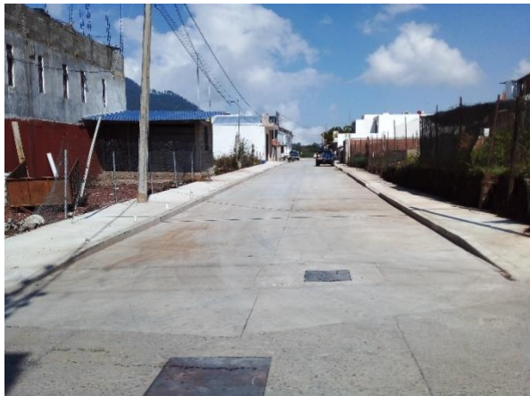
Calle Magisterial, agua, drenaje y pavimento
