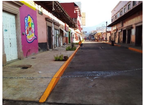
Calle Morelos, agua, drenaje y pavimento
