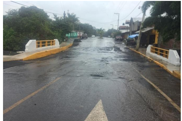
Rehabilitación puente en Pareo
