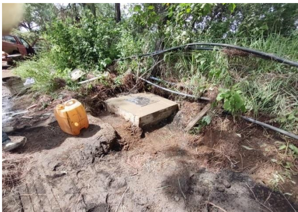
Conducción de línea de agua Zoromútaro
