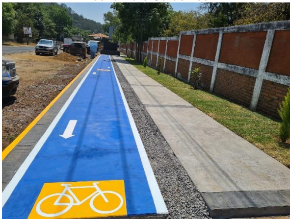
Rehabilitación del Boulevard
