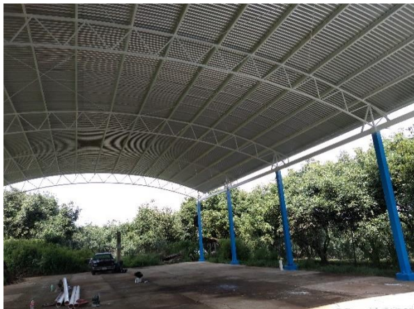
Techumbre Ojos de Agua
