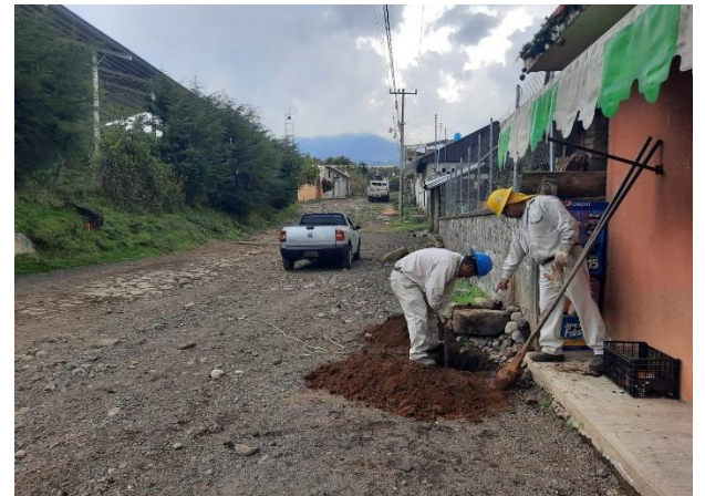
Reubicación línea eléctrica en Zirimóndiro
